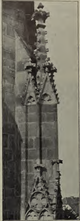
Fig. 22. Hauptkirche, Chor-Strebe- pfeiler.
